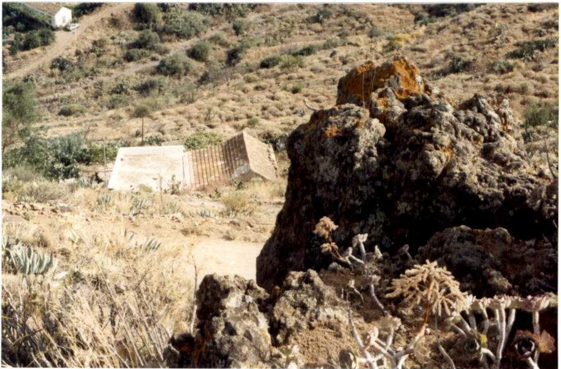
FOTOGRAFIA 6: Vista de la edificación afectada desde la coronación de la zona I.
