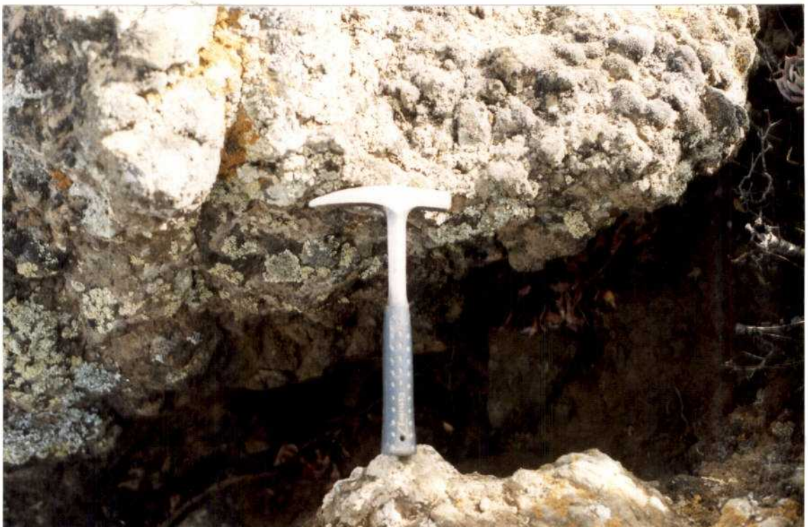
FOTOGRAFIA 7: Vista de la apertura de las grietas en la coronación de la zona I. Los bloques están en un equilibrio inestable "límite".
