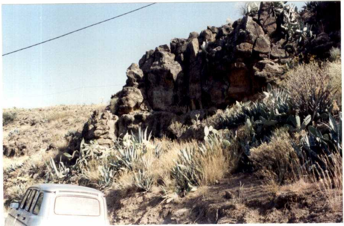
FOTOGRAFIA 3 : Vista del conjunto de bloques inestables de la zona II tomada desde el camino. En el superponible aparecen los bloques a sanear.
