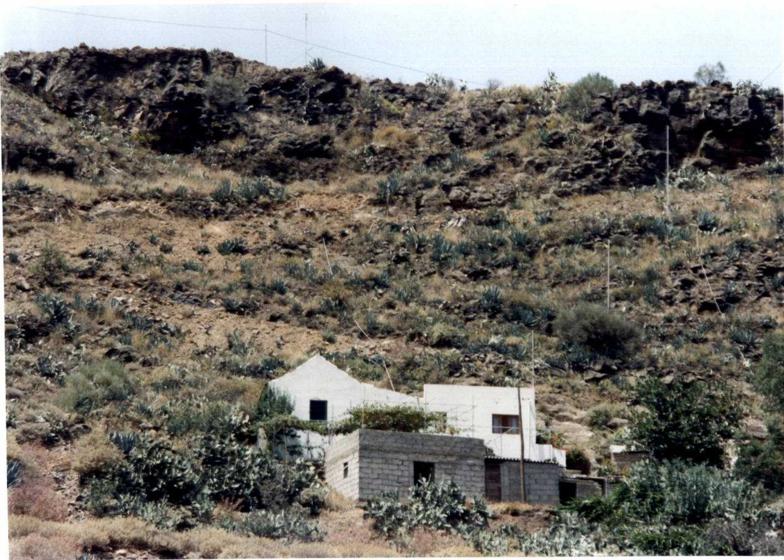
FOTOGRAFIA 1: Vista de las 2 zona con bloques inestables, así como de la viviendas que podría ser afectada por los desprendimientos de roca.
